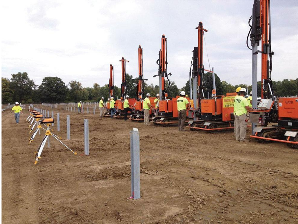
Слика 14. Приказ на машинерија за набивање на столбовите во земја
