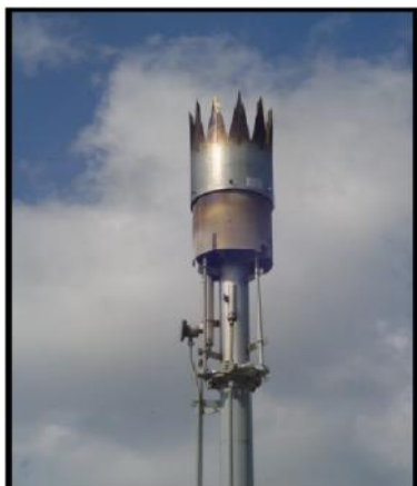
Слика 24. Рамка со шилци околу горниот дел од факелот
