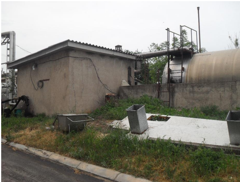
Слика 7 Резервоар за мазут со пумпна станица
