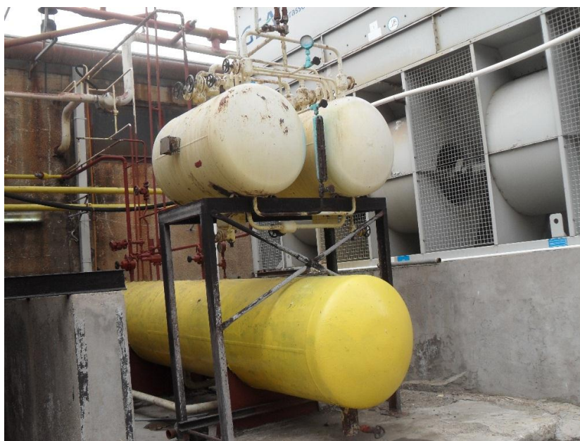
Слика 6 Резервоар за течен амонијак
