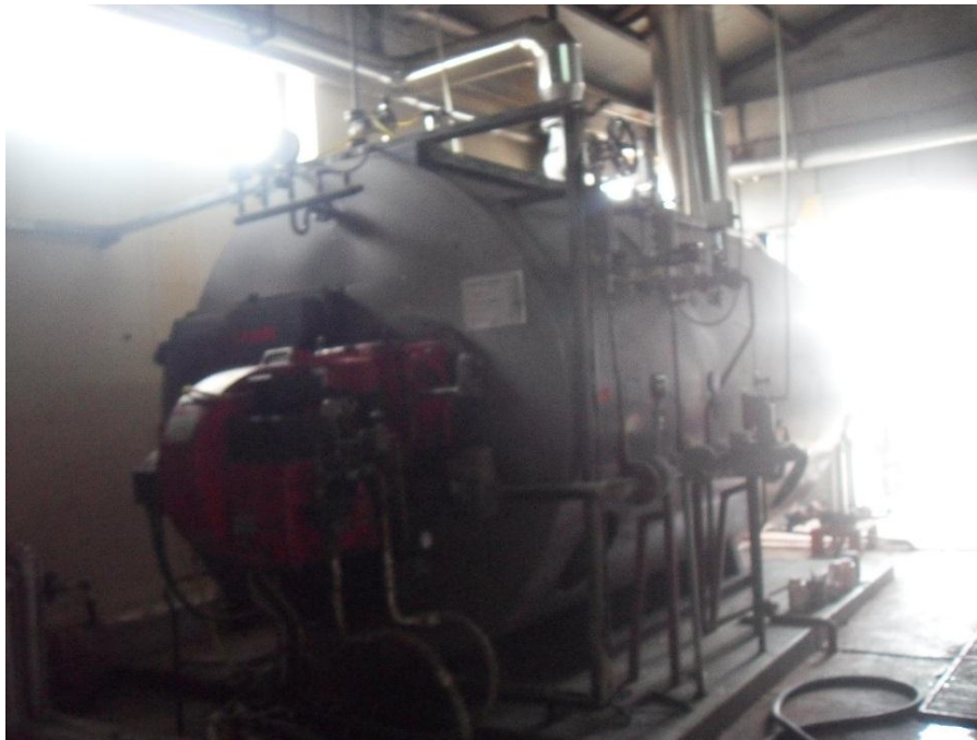
Слика 3 Нов котел во котлара
