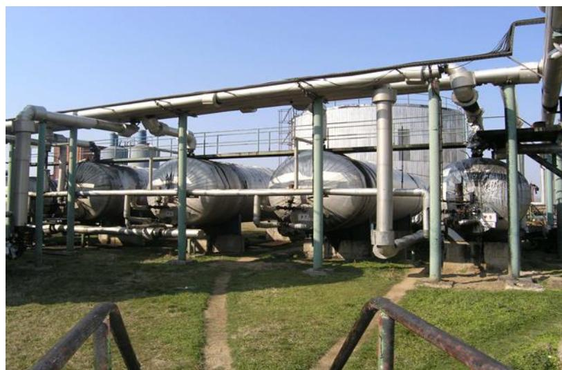
Слика 2. Резервоари за складирање на битумен
