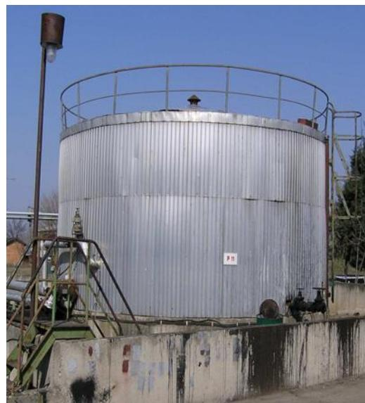
Слика 4. Резервоар за битумен
