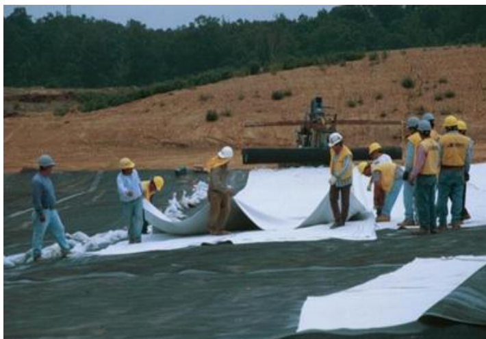
Слика5: Изградба на подлога на дното
