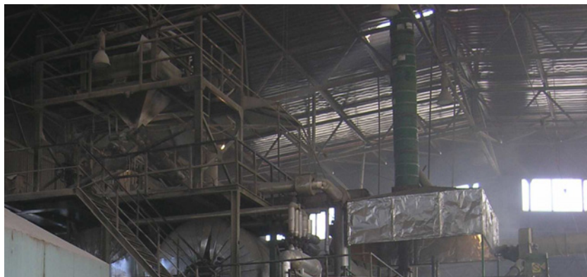
Слика 25. Хауби и канали за вентилирање на органски соединенија
