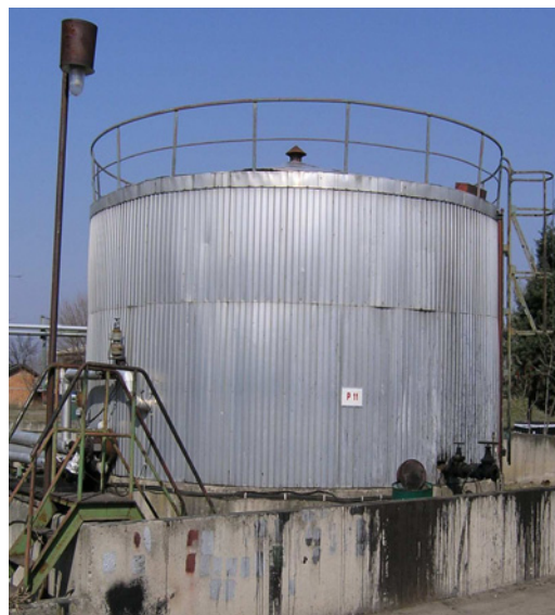
Слика 4. Резервоар за битумен
