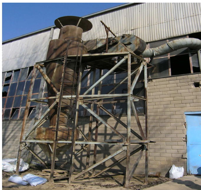
Слика 13. Систем за отпрашување
