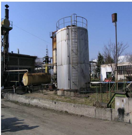
Слика 3. Резервоари за мазут и термално масло
